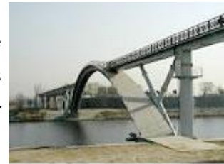
Vista lateral Puente de la Paz
