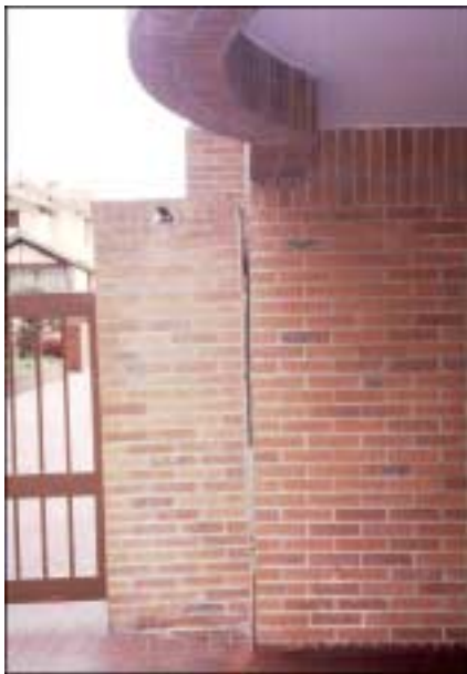
Figura 2 – Dilatación en la placa de la plataforma de un piso donde aparentemente se ha formado una fisura indebida.
