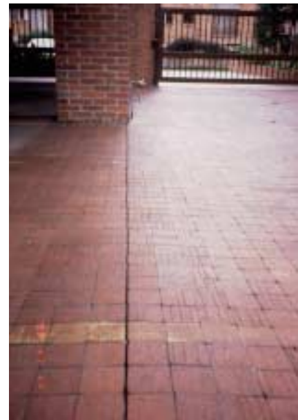
Figura 2 – Dilatación en la placa de la plataforma de un piso donde aparentemente se ha formado una fisura indebida.
